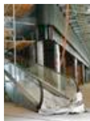
Baustelle Stücki. lub
